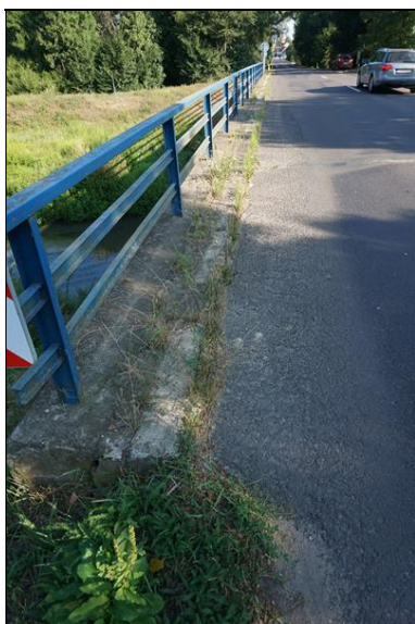
Detail pravé strany vozovky, vegetace, převrstvená vozovka.
