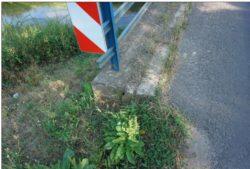
Nenávaznost říms na pravé straně u opěry OP2.
