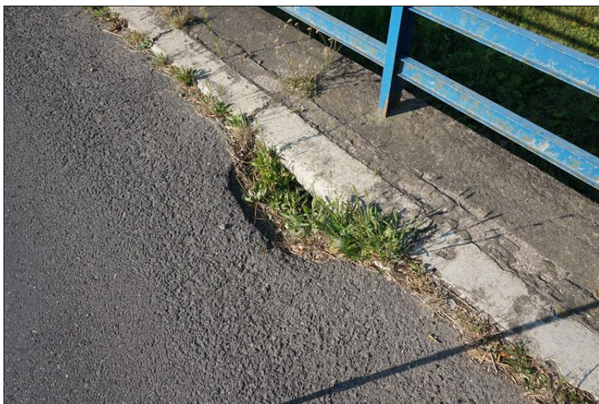
Detail pravé strany vozovky, vegetace, převrstvená vozovka.
