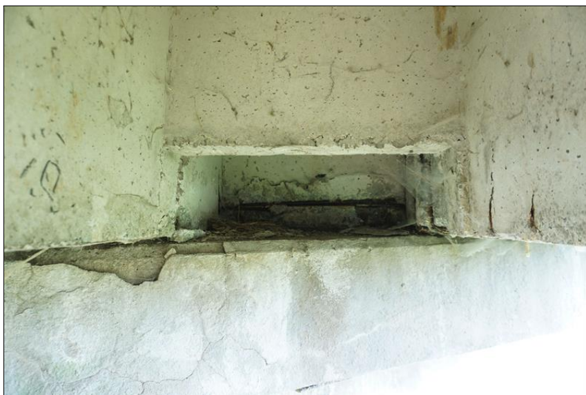
Detail úložného prahu pilíře P2, vyrůstající vegetace.
