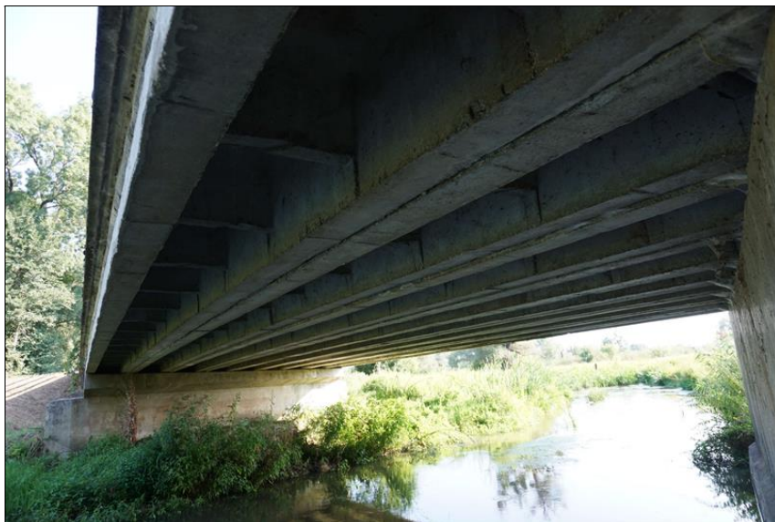
Detail pohledu nosné konstrukce, odpadávající vrstvy betonu až na nosnou výztuž, která koroduje.
