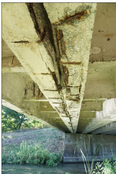
Detail pohledu nosné konstrukce, odpadávající vrstvy betonu až na nosnou výztuž, která koroduje.
