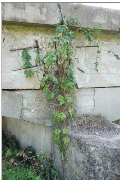
Detail úložného prahu pilíře P2, vyrůstající vegetace.
