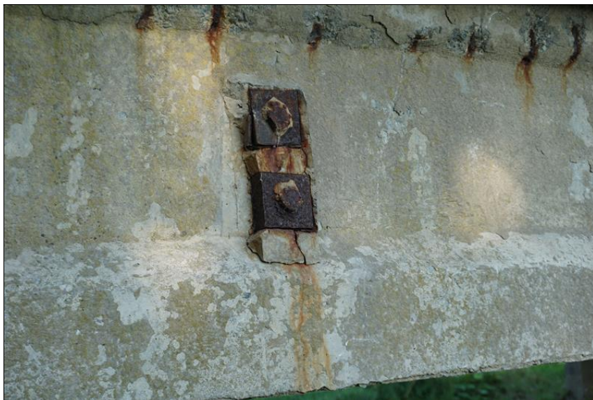
Detail levé strany nosné konstrukce, obnažené kotvy příčného předpětí.
